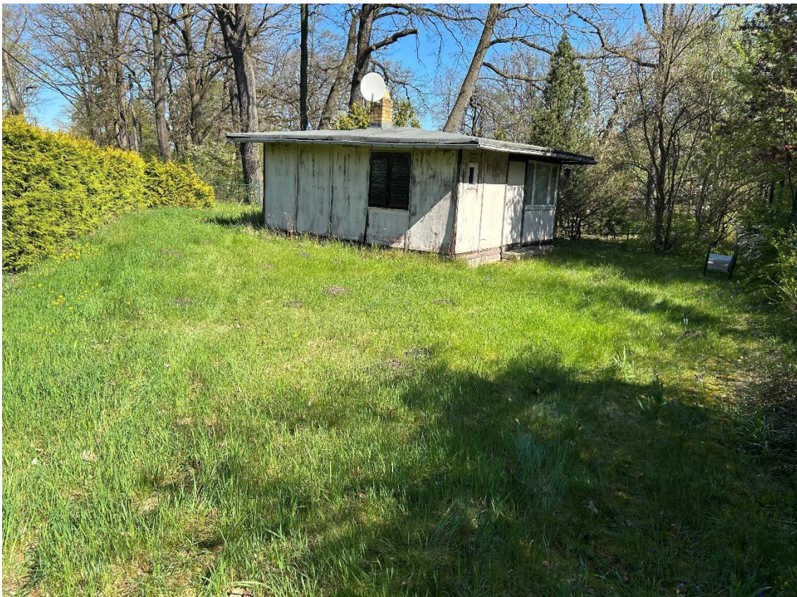
Blick auf das Grundstück zur Nordseite
